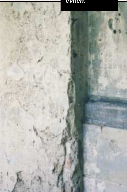
Pussen på universitetsbygningene hadde på store områder nesten gått i oppløsning under plastfilmen.
