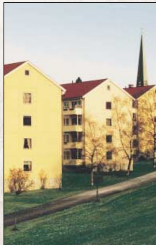
Tonsenjordet Borettslag. Fjerning av gammel maling og oppmaling av 17 boligblokker. Tilsammen 21.000 m 2 fasadeflate. Utført i 1989 - 1993.
