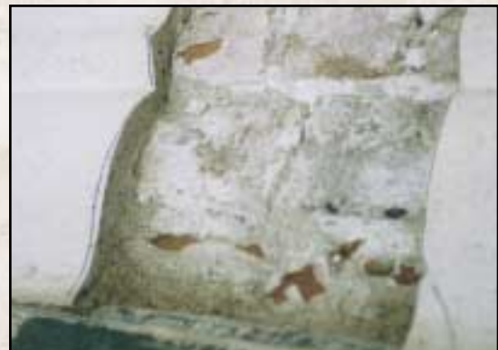
Rettskårne pusskanter gir en betydelig kvalitetsforbedring på pussutbedringene.
