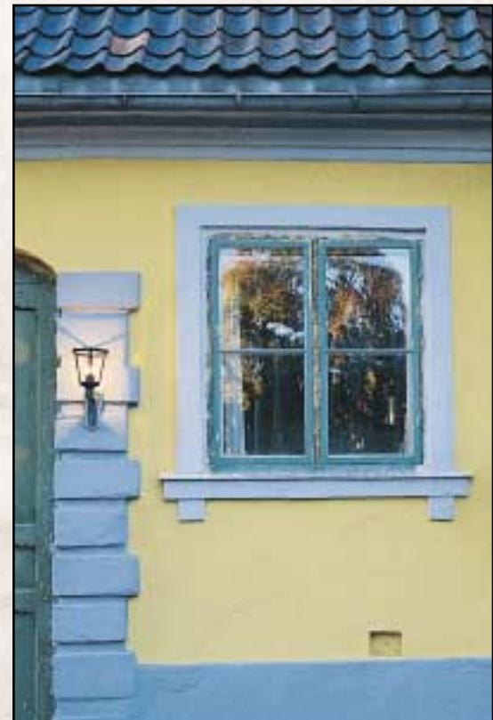
Den ferdigbehandlede fasaden. Utført i 1987.
