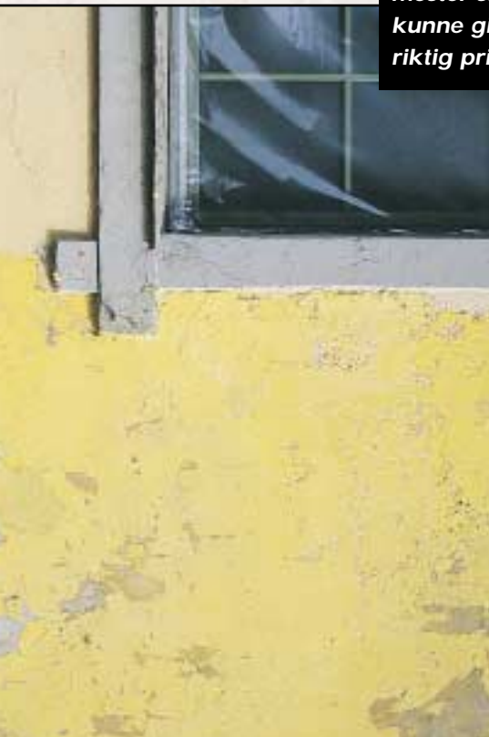
Moss bryggeri. 17 lag gammel maling må fjernes. Administrasjonsbygningen ble oppført i 1830.
